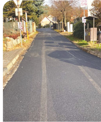
Čerstvo opravený povrch Štítovej ulice, december 2023.
